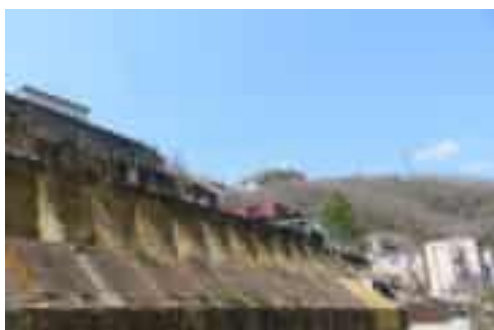
中央立坑の趾
