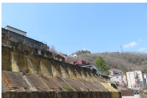
中央立坑の趾
